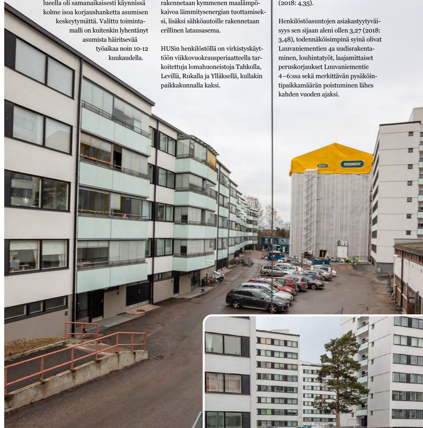
Helsingin Niemenmäen asuinalueella oli vuonna 2019 samanaikaisesti käynnissä kolme isoa korjaushanketta asumisen keskeytymättä.
